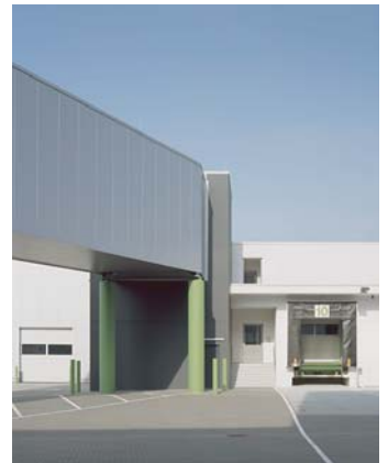
Förderbandbrücke von Nordenia Deutschland zur Multifunktionshalle und weiter zum Blocklager
