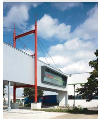
Förderbandbrücke von Nordenia Deutschland zur Multifunktionshalle und weiter zum Blocklager
